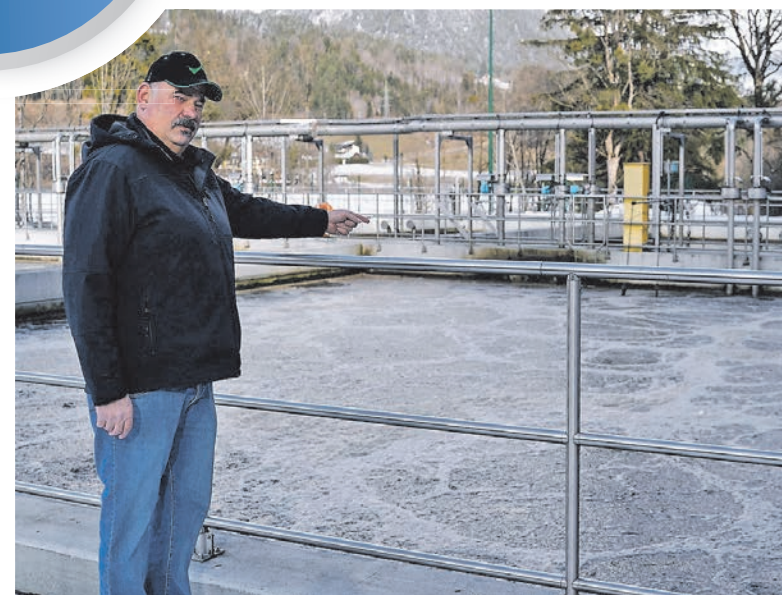
Klärmeister Kleer vor dem „Herzstück“ der Kläranlage Schladming, dem Belebungsbecken.
